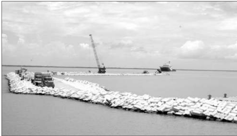
▲ Las obras a las que la Apicam destinará 3 millones 150 mil pesos son el cambio de torre de comunicación, retiro de pilotes en muelles y ampliación del alumbrado público. Foto Gabriel Graniel
