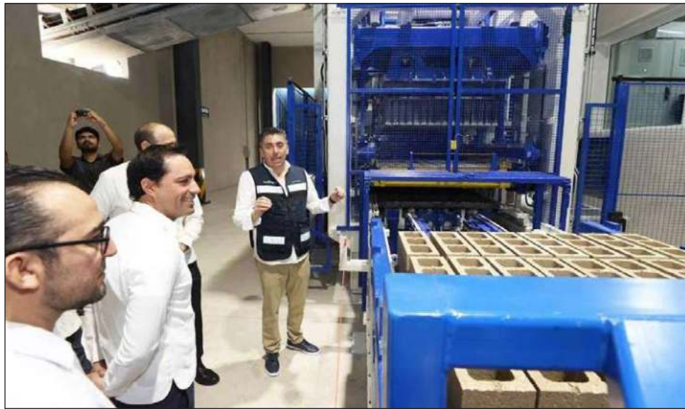
▲ La planta bloquera tiene una capacidad de producción de 29 millones de piezas al año, mismas que serán comercializadas en la región Sur-Sureste. Foto @MauVila
