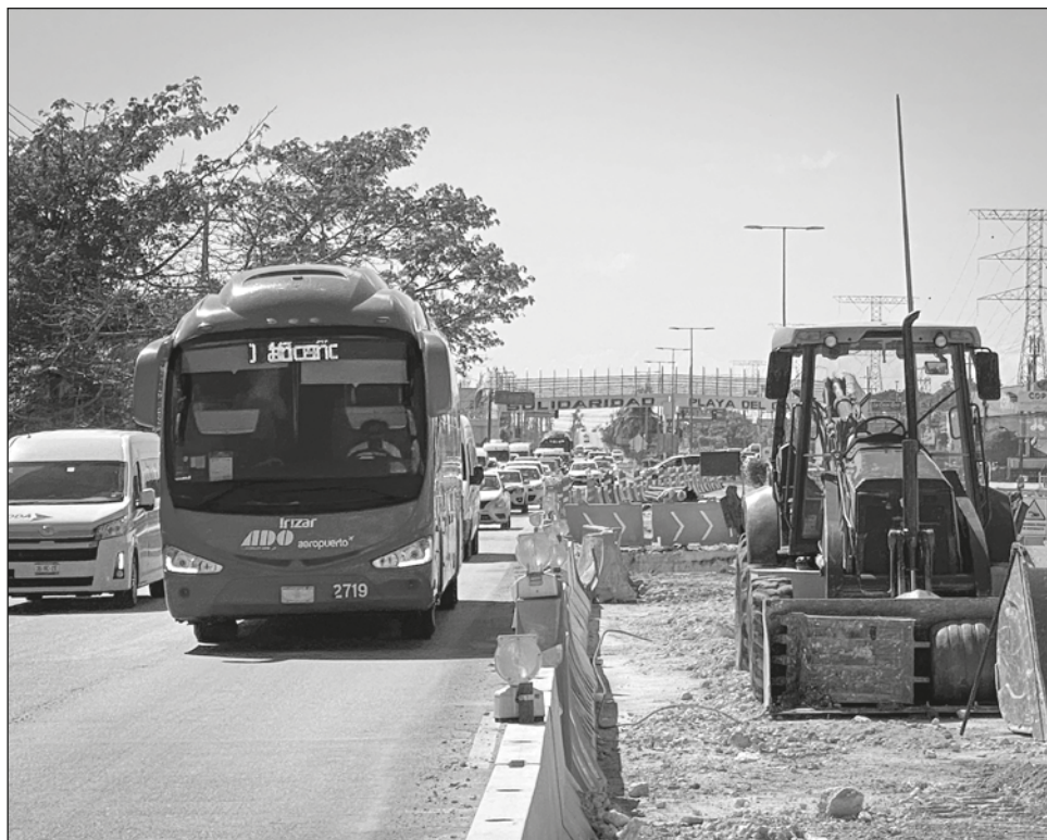
▲ En Playa del Carmen sigue parada la maquinaria a la entrada de la ciudad, en medio del camellón central de la carretera federal. Foto Juan Manuel Valdivia
