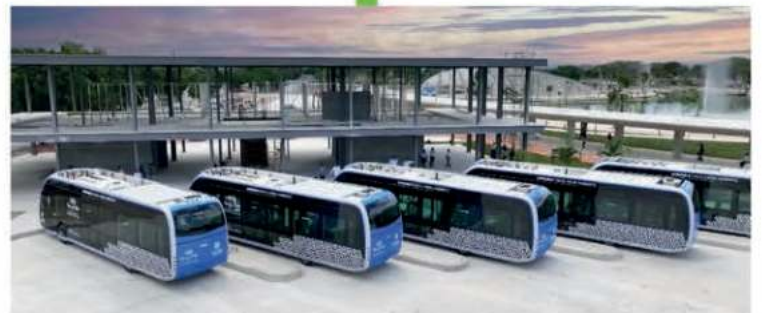
Se construye la estación del IETRAM en el Parque la Plancha, para 3 rutas de este transporte público 100% eléctrico y único en su tipo en Latinoamérica.
