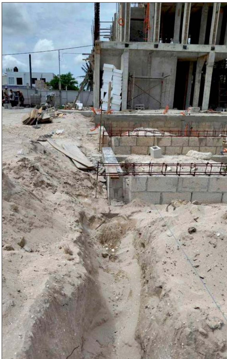
“Es muy triste ver una nido en la playa de Telchac identificado y que delante de él está lleno de bloques, cabillas y material de construcción”. Foto Facebook Anne Treinen
