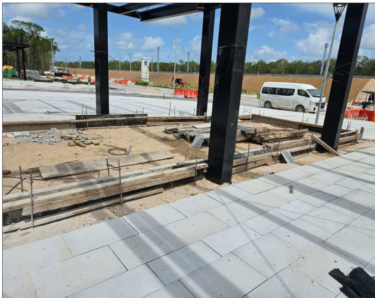
▲ David Jáuregui destacó que hace dos años utilizaron más de 15 mil toneladas de sargazo para fabricar mil 800 metros cúbicos de concreto, empleados en la construcción de aproximadamente 17 mil metros cuadrados de piso del Tren Maya de Tulum. Foto Miguel Améndola
