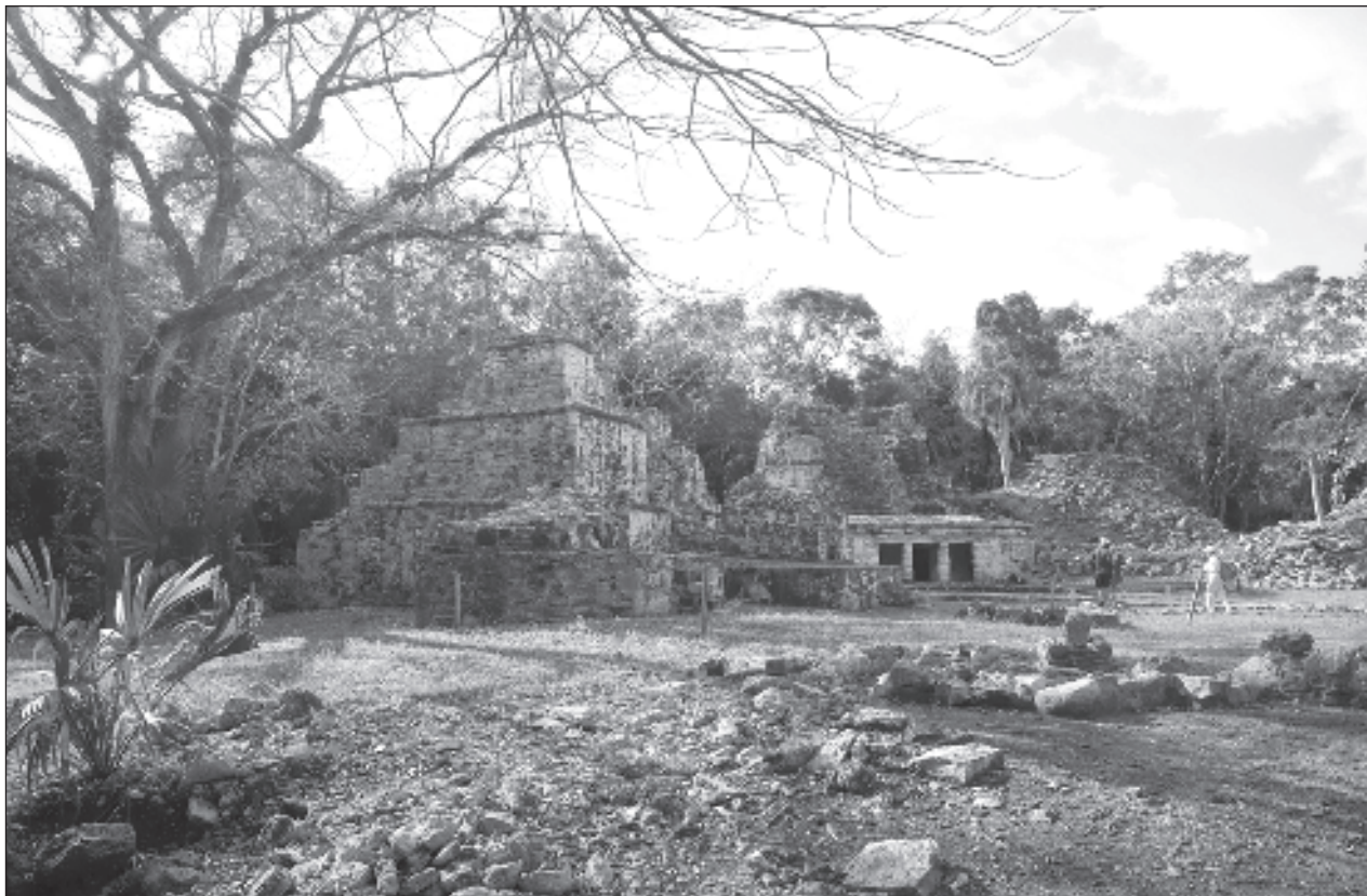
▲ Muyil se mantuvo cerrado durante la segunda parte del año pasado, mientras se realizaba la construcción de un área de servicios, con taquilla, estacionamiento y sanitarios, así como la instalación de señalética. Foto Juan Manuel Valdivia
