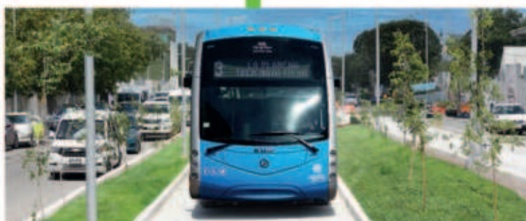
Construcción de vías en donde transitarán las unidades del IETRAM, además de construcción de banquetas y guarniciones, señalética, sistema de iluminación y pozos pluviales.
