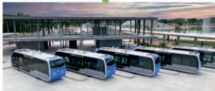
Se construye la estación del IETRAM en el Parque la Plancha, para 3 rutas de este transporte público 100% eléctrico y único en su tipo en Latinoamérica.
