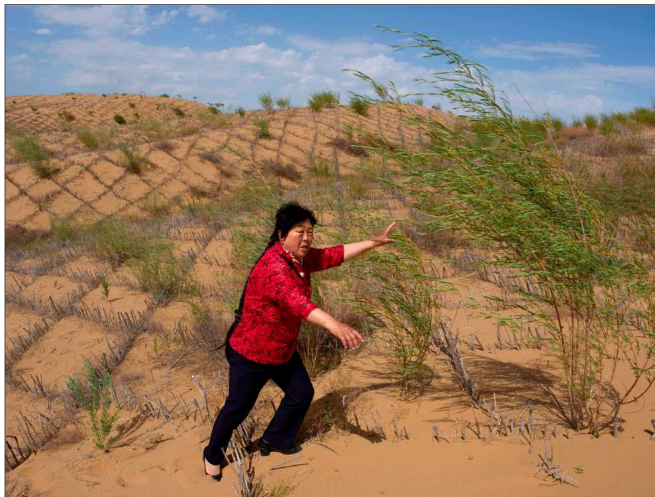
▲ La técnica, conocida como ‘tableros de ajedrez de paja’, es un método sencillo pero ampliamente utilizado para estabilizar las dunas de arena frente al viento y ayudar a que las plantas echen raíces con agua suministrada a través de un sistema de riego. Foto Ap
