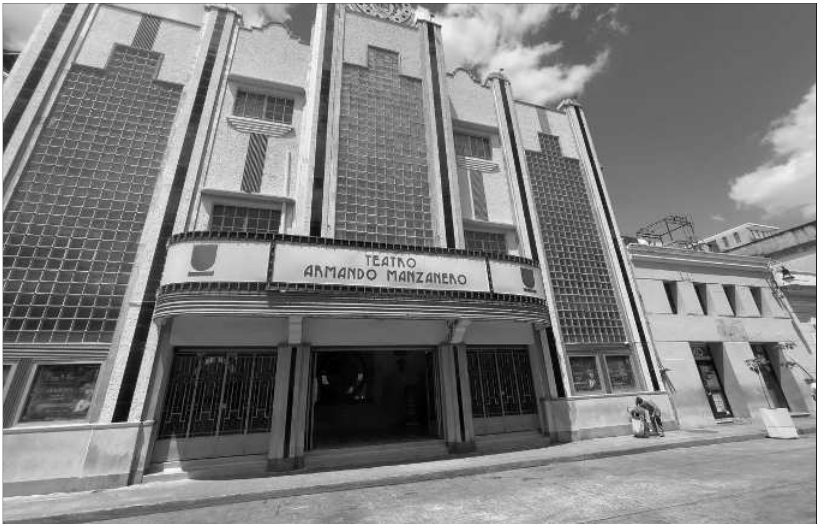
▲ En el recinto se hizo impermeabilización y mantenimiento en baños, camerinos e instalación eléctrica, pintura de la fachada y los vestíbulos, entre otras acciones. Foto jusaeri
