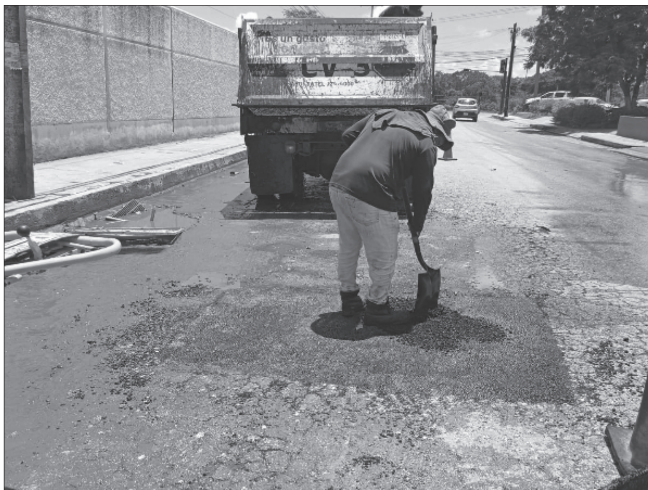
▲ Personal de Obras Públicas trabajaron sobre la calle 110 por 81 y avenida Internacional. Foto ayuntamiento de Mérida
