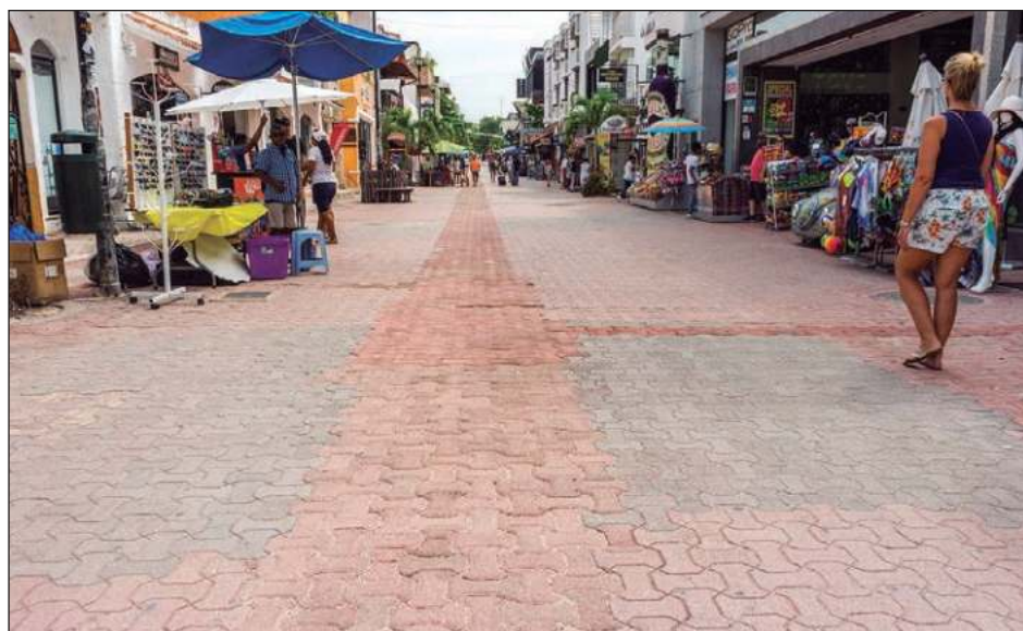
▲ Las maniobras consistirán en el remplazo de 131 metros de tubería de PVC de 8 pulgadas, las cuales se estarán ejecutando durante el periodo de abril a julio. Foto Aguakan
