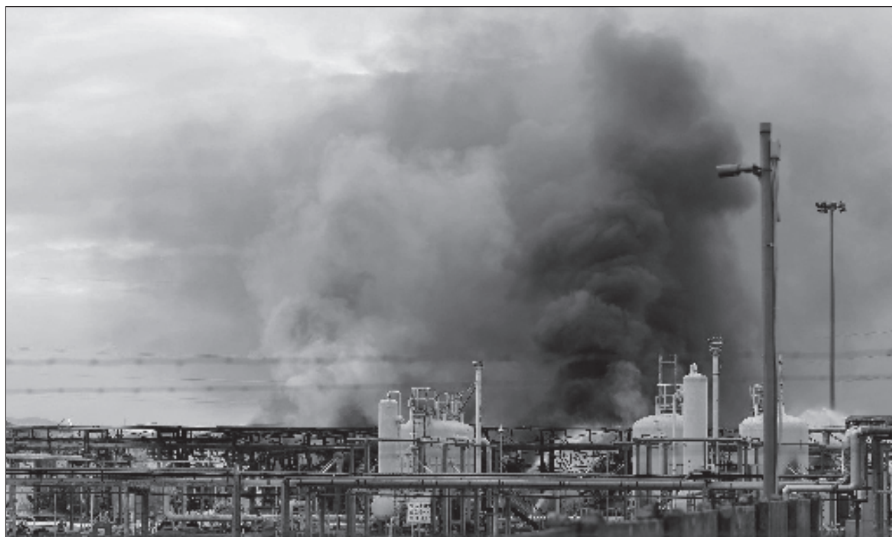
▲ La explosión en un depósito de combustible de ENI provocó una columna de humo que se elevó en el cielo. Foto Afp
