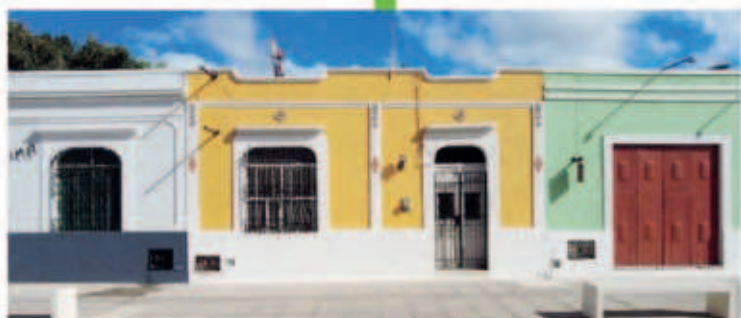
El Ayuntamiento de Mérida invirtió en la pintura en las fachadas de las viviendas que rodean al Parque de la Plancha.
