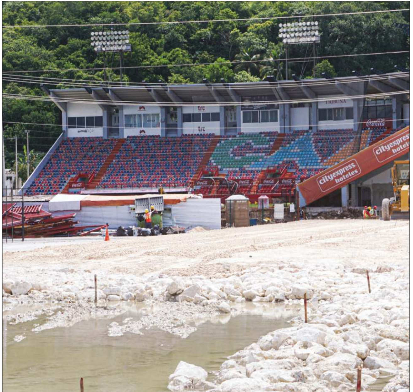
▲ La Escuela de Beisbol, indicó Karla Sánchez, titular de la Seduopi, no cumple ni 50 por ciento de la norma estructural de espacios educativos, y tampoco se sabe dónde están los 46 millones de pesos que dio el gobierno federal para la obra. Foto Fernando Eloy
