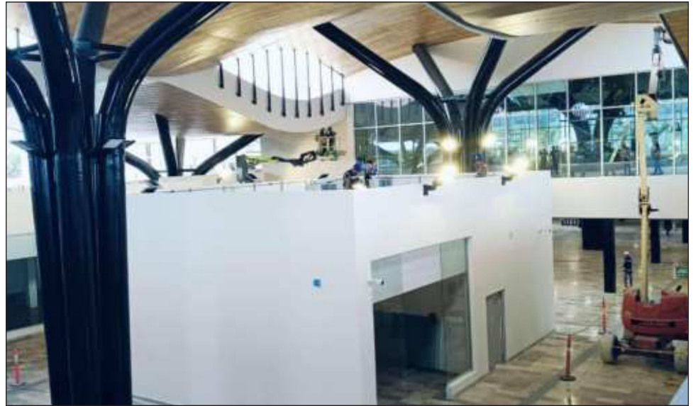
▲ Pese a que la estación en Tulum del Tren Maya está prácticamente concluida, trabajadores del mega proyecto estiman que entre en operaciones en semana y media. Foto Miguel Améndola
