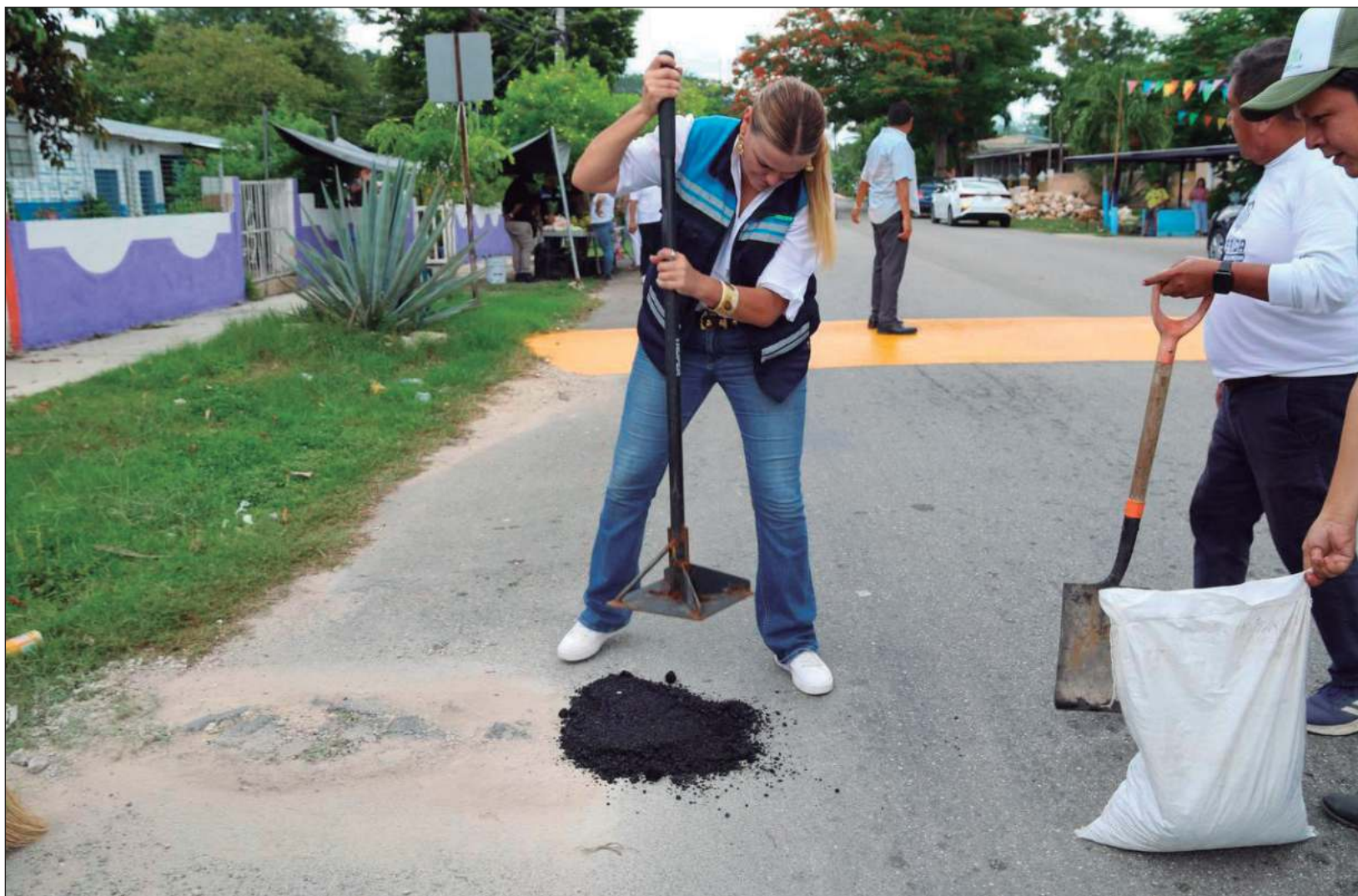
▲ A través de Obras Públicas, Patrón informó que del 1 de septiembre se han realizado más de 250 mil metros cuadrados de reparación. Foto ayuntamiento de Mérida
