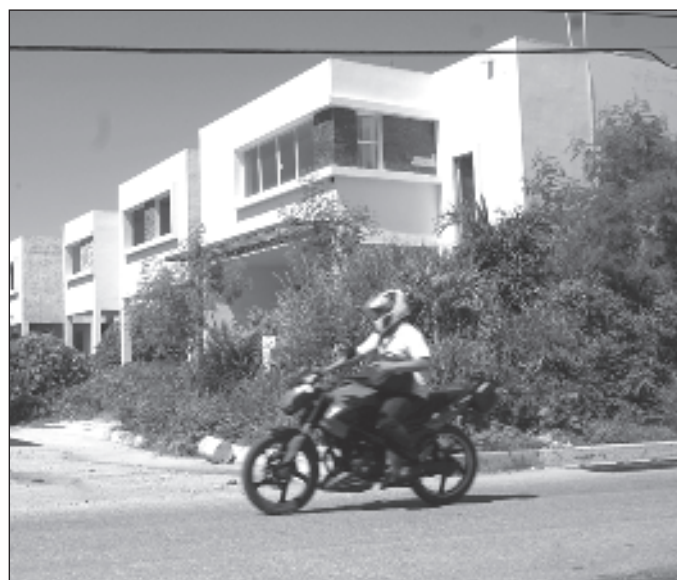
▲ Resulta encomiable que en este trimestre inicie la construcción de más de 52 mil viviendas de interés social. Foto Fernando Eloy
