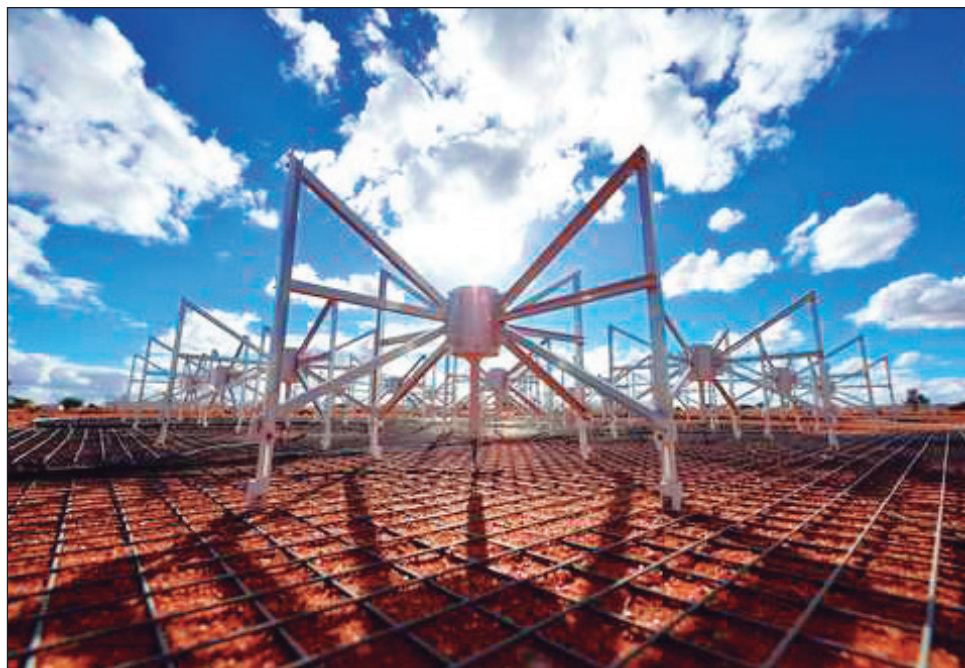
▲ Las Antenas dipolo del telescopio Murchison Widefield Array se encuentran en Australia Occidental. Foto Icarar/ Dragonfly Media
