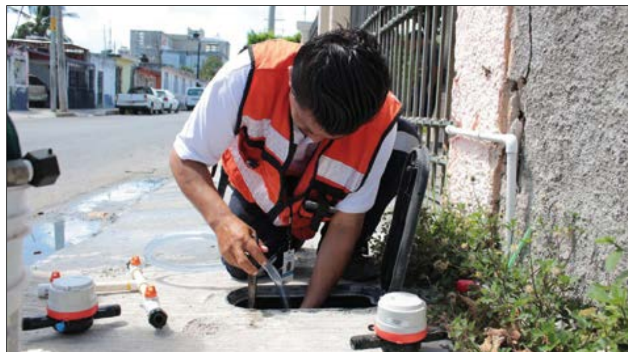
▲ Un supervisor de la brigada revisará el medidor, línea externa, tinaco o cisterna en busca de posibles fugas. Foto Aguakan
