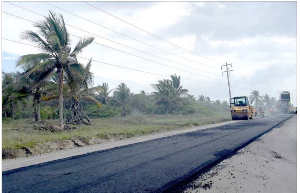
▲ Además del mantenimiento permanente que se realiza en distintos tramos carreteros, en los próximos días comenzarán las labores de conservación periódica. Foto jusaeri
