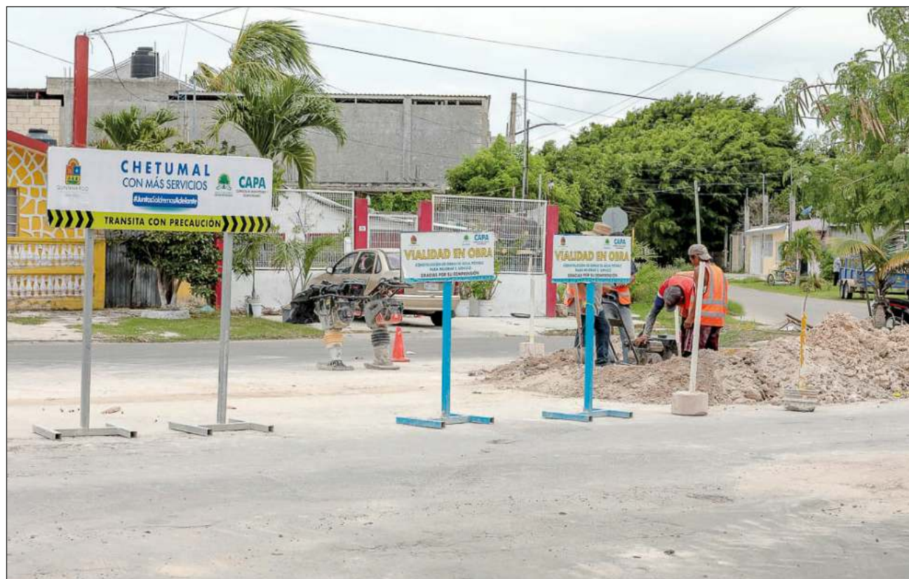
▲ En la capital del estado, la Secretaría de Obras Públicas proyecta una inversión de 200 mdp para la primera etapa de la remodelación del bulevar Bahía. Foto CAPA
