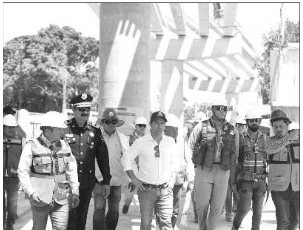
▲ El gobernador realizó un recorrido por los trabajos que se llevan a cabo sobre la calle 82 del centro de Progreso, donde atestiguó la colocación de trabes. Foto gobierno de Yucatán
