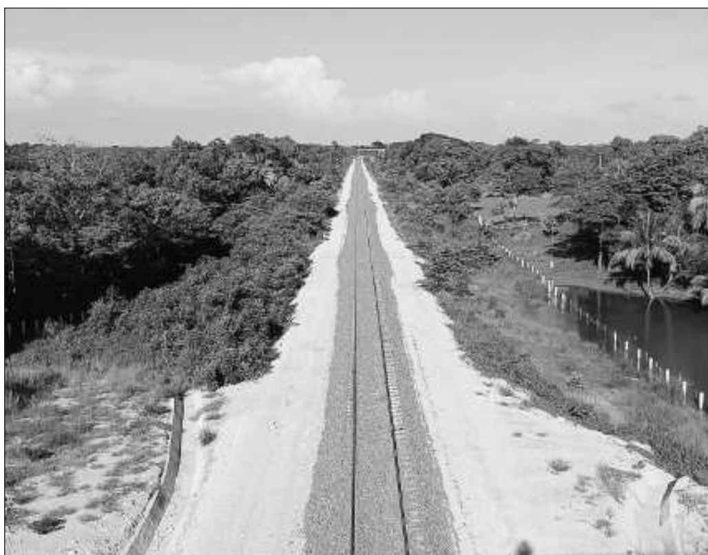
▲ El desarrollo de la obra se ha convertido en una carrera a contrarreloj. Era algo esperado, pues el menor avance se tiene en los tramos 5, 6 y 7, que atraviesan Quintana Roo y el sur de Campeche. Foto Emilio Gómez
