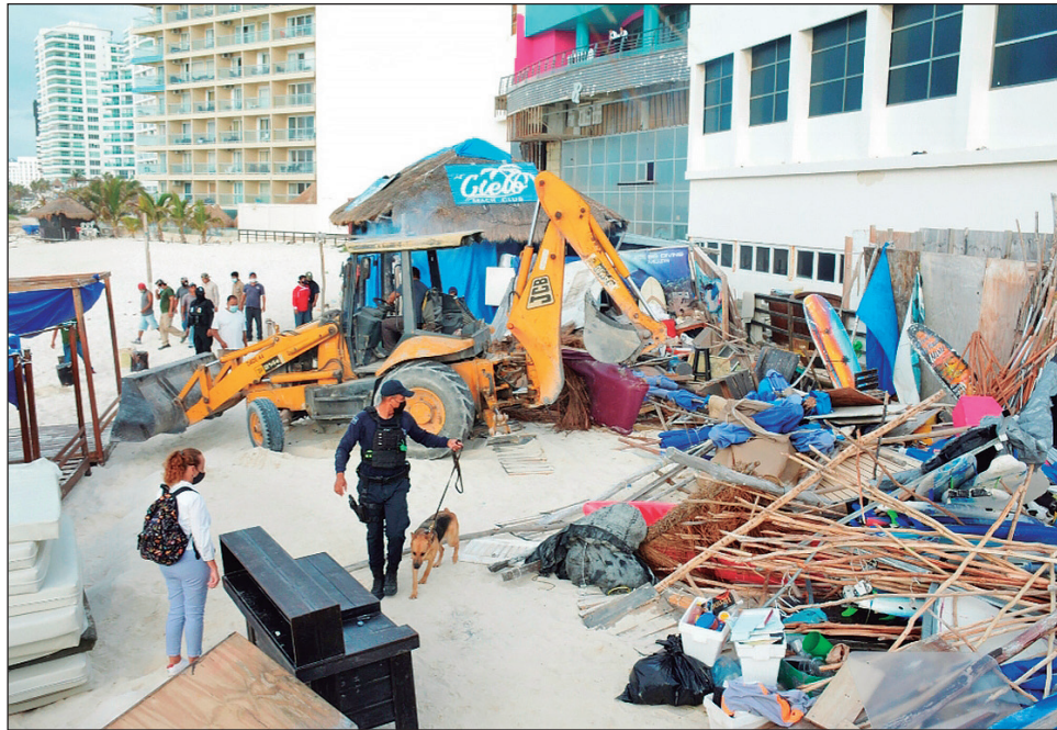
▲ En el operativo utilizaron volquetes y maquinaria pesada para demoler una palapa del club Cielo Beach. Foto Fiscalía de Quintana Roo
