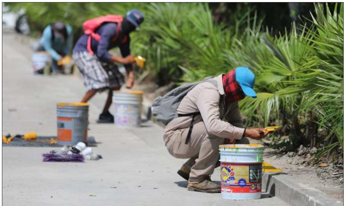
▲ Trabajadores de la Dirección General de Servicios Públicos realizaron acciones como corte de maleza, poda de árboles, limpieza y pintura de guarniciones. Foto ayuntamiento de Puerto Morelos
