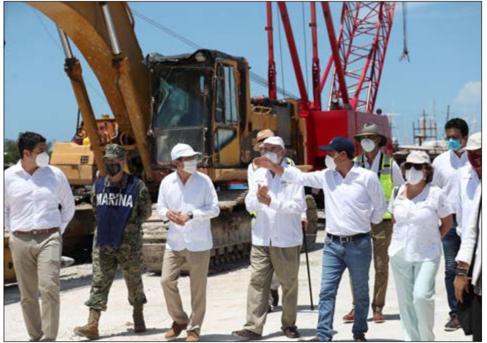
▲ Las obras de rehabilitación en Yucalpetén son las más importantes que se han realizado en los últimos 50 años. Foto Comunicación gobierno de Yucatán
