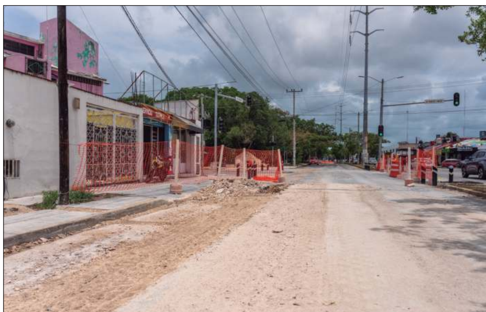
▲ Más de 42 kilómetros de tubería serán renovados en las supermanzanas 91 y 92 como parte del compromiso con la mejora continua del servicio. Foto Aguakan
