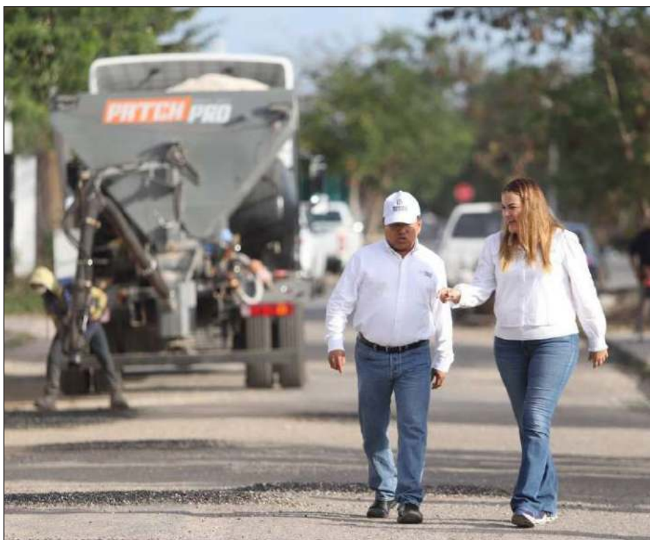
▲ El programa permanente de bacheo, parte de los esfuerzos para mejorar la infraestructura vial de la ciudad, aseveró la alcaldesa Cecilia Patrón. Foto ayuntamiento de Mérida
