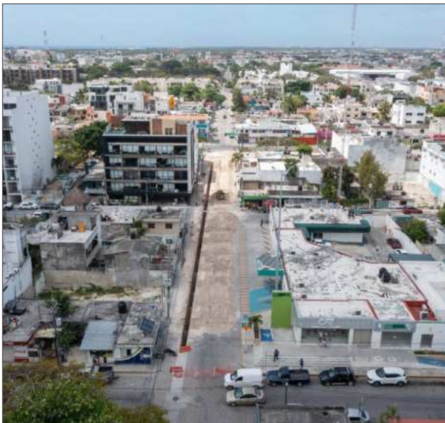
Con estas obras, se beneficiará a más de 29 mil habitantes de la zona. Foto Aguakan
