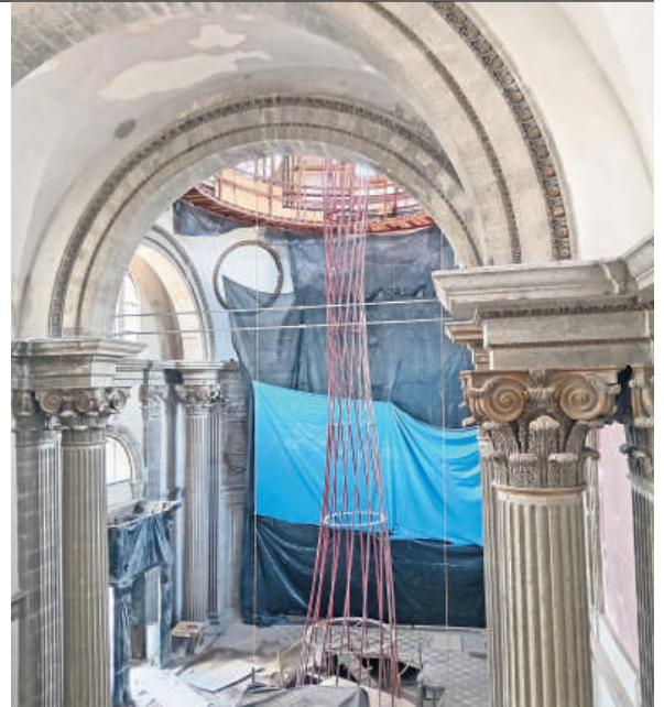
▲ Cilindro helicoidal que funciona como sostén del piso y se colocó en el crucero del templo. Foto: Xavier Guzmán Urbiola.
