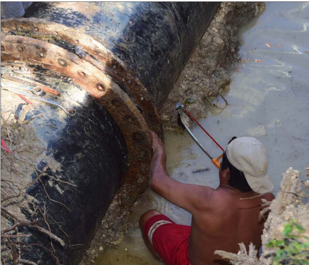
▲ El objetivo principal es conectar el acueducto de Hobomó con la red troncal de Campeche, lo que permitirá mejorar la distribución del vital líquido en toda la ciudad; la CAPAE será responsable de supervisar el proyecto. Foto Fernando Eloy
