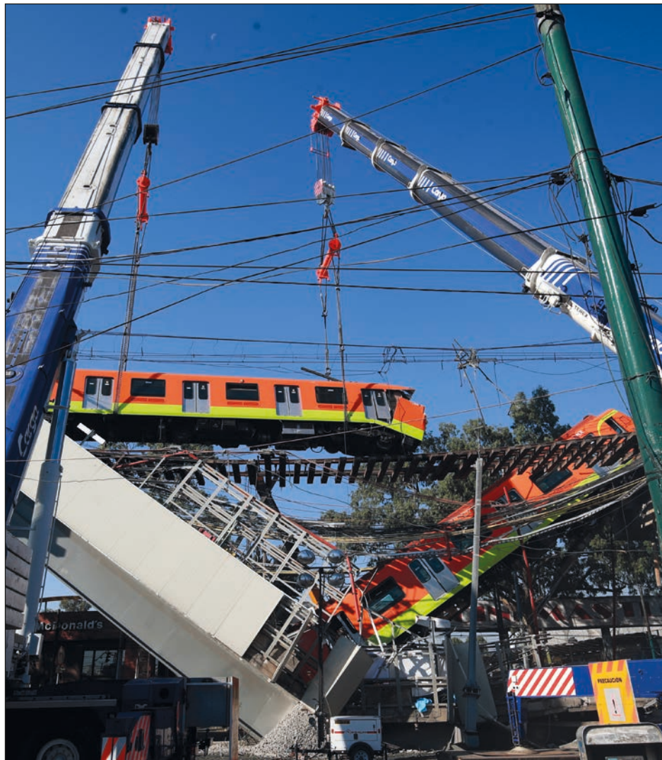
▲ La construcción del tramo vencido el 3 de mayo estuvo a cargo de Carso. Foto Luis Castillo
