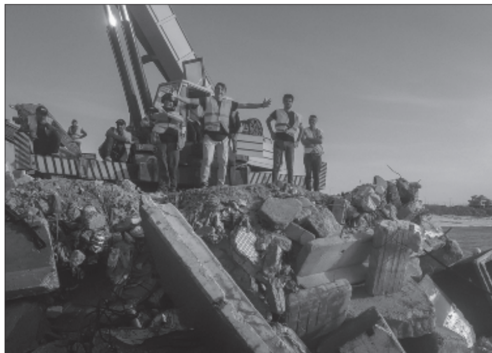
▲ En Deir Balah, voluntarios de World Center Kitchen construyeron un espigón con los escombros de los edificios bombardeados para poder desembarcar la ayuda. Foto @campscar
