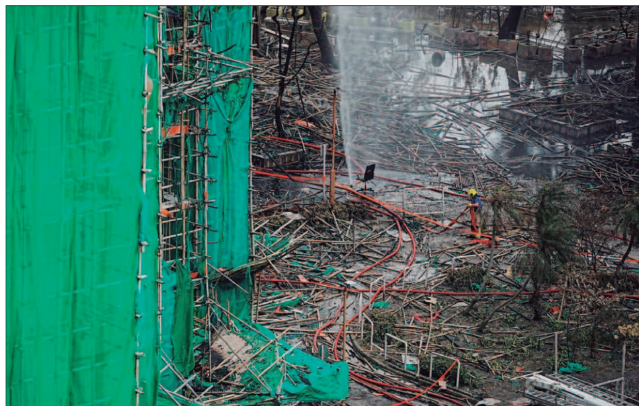
▲ Las llamas se propagaron rápidamente a través de las mallas plásticas que cubrían andamios de bambú instalados para las obras y que no cumplían las normas de resistencia al fuego; hay 15 personas detenidas por homicidio involuntario. Foto Reuters
