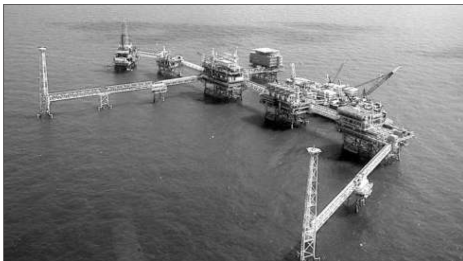
▲ A bordo de la plataforma Zaap Charly han fallado los aires acondicionados en el área habitacional, y ahora el cuarto de refrigeración de alimentos. Foto Gabriel Graniel Herrera
