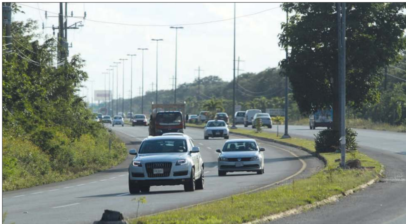
▲ El trayecto corresponde al tramo 5 Sur y los dos carriles serán construidos en el camellón central. Foto Juan Manuel Valdivia
