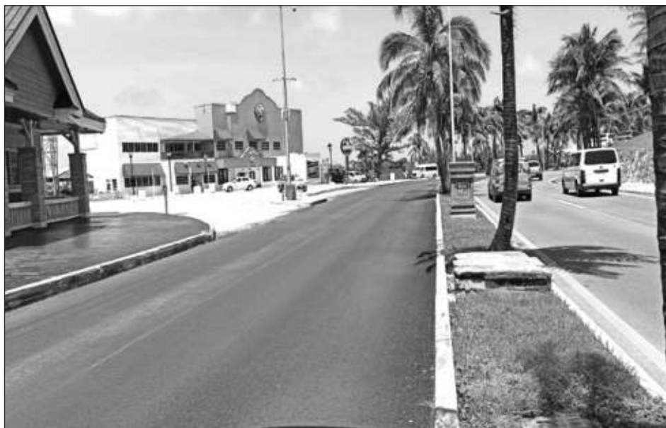
▲ Se rehabilitaron un total de 12.7 kilómetros en ambos carriles de la vía. Foto Fonatur
