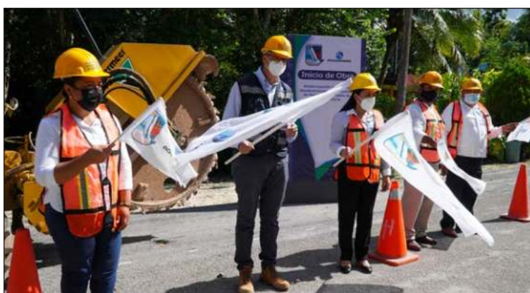
▲ Los trabajos consisten en la rehabilitación y remodelación del pozo, así como un tanque de almacenamiento. Foto Aguakan
